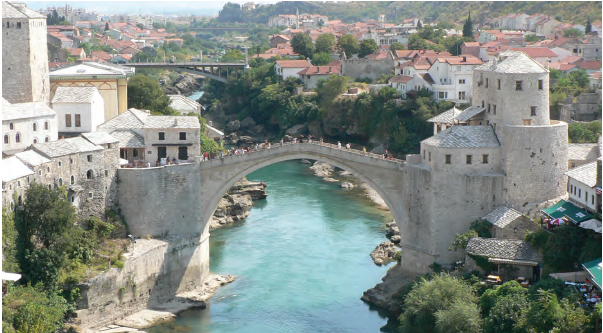
Fotoğraf 6.80: Mostar Köprüsü, Bosna - Hersek
